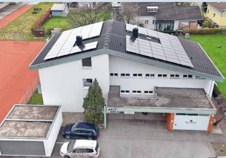
Neue 34,4 kWp PV-Anlage auf dem Dach des Arzthauses
