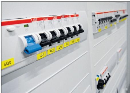
Sollte nämlich aus irgendwelchen Gründen die Mechanik versagen, löst der Schalter bei Verwendung eines defekten Gerätes nicht mehr aus. Folge: die gesamte Spannung kann direkt am Gerät/Gehäuse anliegen, was in etwa einem Griff direkt in den Stromkreis gleichkommen kann.
