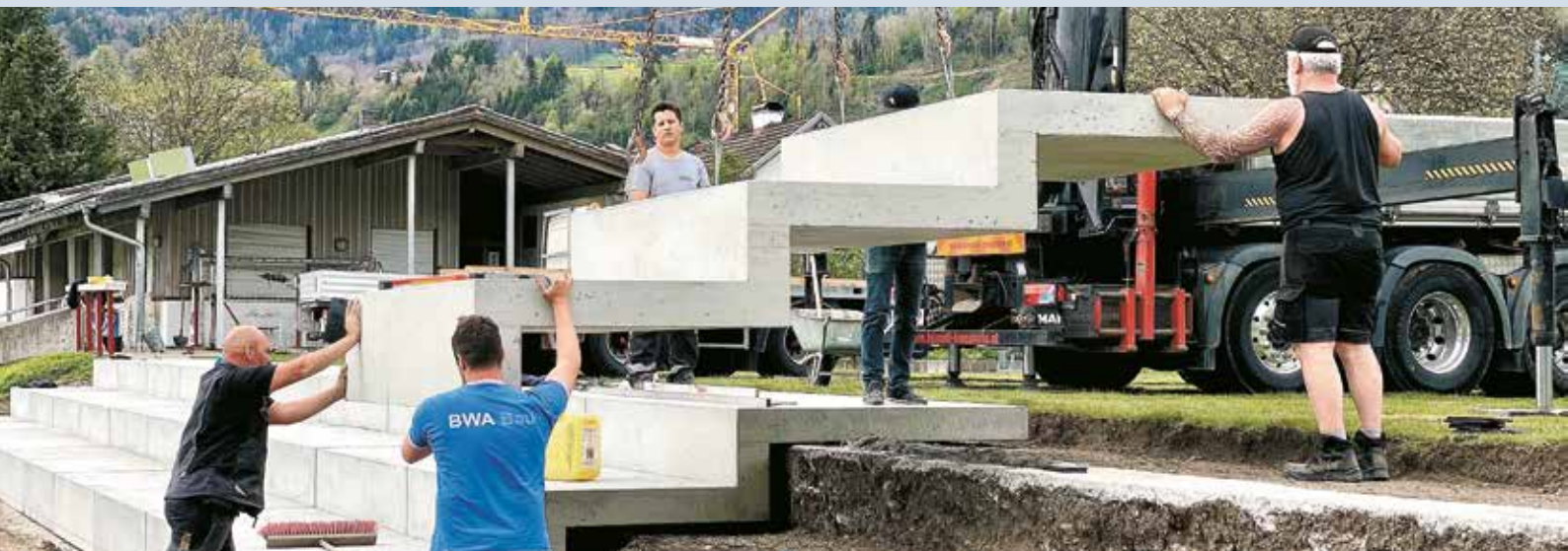
Montage der neuen Tribüne am Sportplatz
