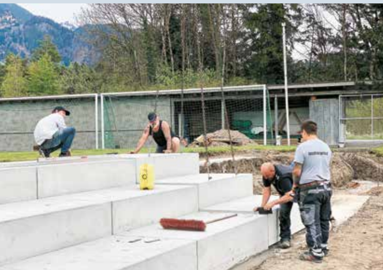
Mitarbeiter beim Positionieren der Fertigteilelemente
