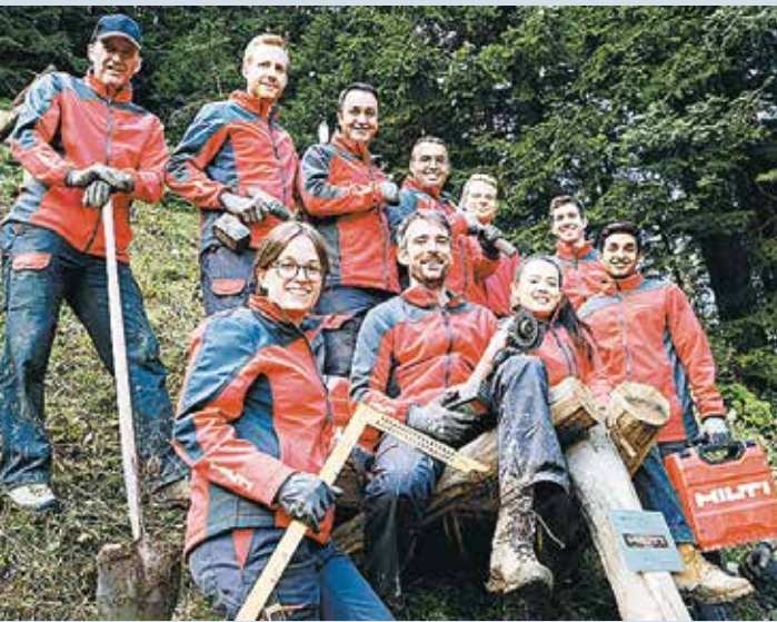
Hilti Team bei Lawinerverbauung
