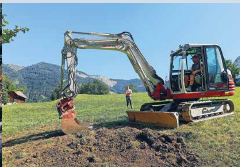
Tschüggi bei Probegrabungen für das geplante Hochwasserentlastungsprojekt Montjola
